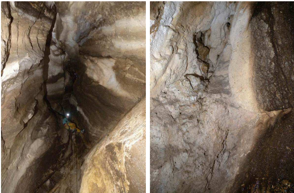
Abbildung 69 – Glockenschacht, Blick Richtung Eingangsbereich hinauf, Bergmilch am Schachtgrund
